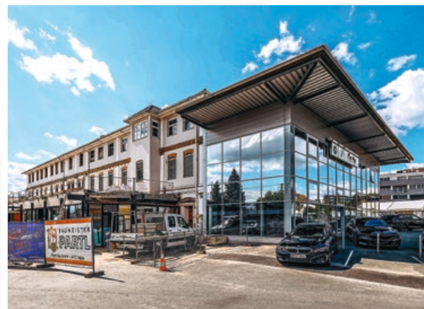
Planmäßig dauern die Bauarbeiten noch bis Sommer 2027 an.
